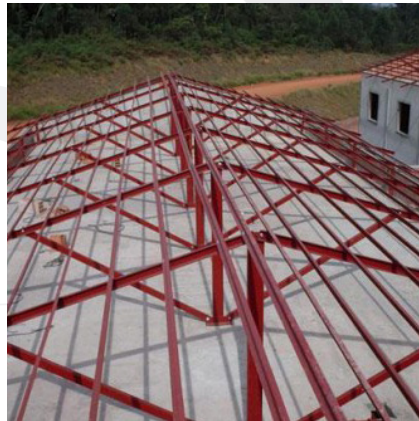
Estrutura metálica do telhado
