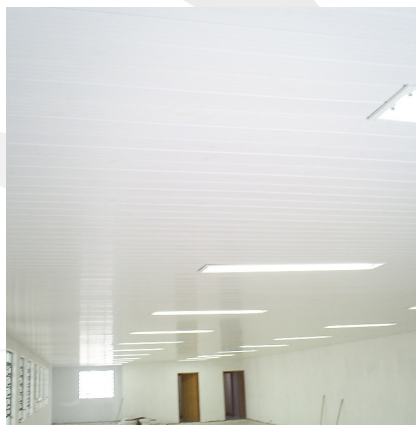
Forro de PVC em bom estado
