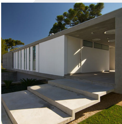
Cobertura em concreto
