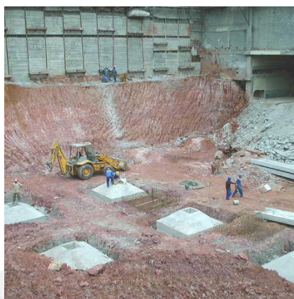
Execução sapatas de fundação
