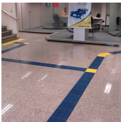
Piso tátil interno
