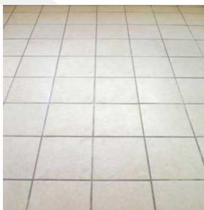
Piso cerâmico em bom estado
