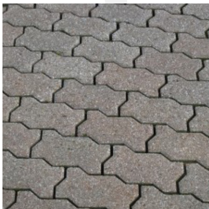
Piso em blocos de concreto
