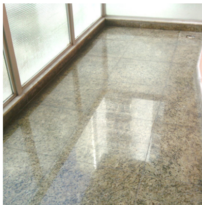
Piso em bom estado de conservação
