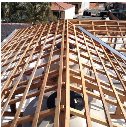
Estrutura do telhado em madeira
