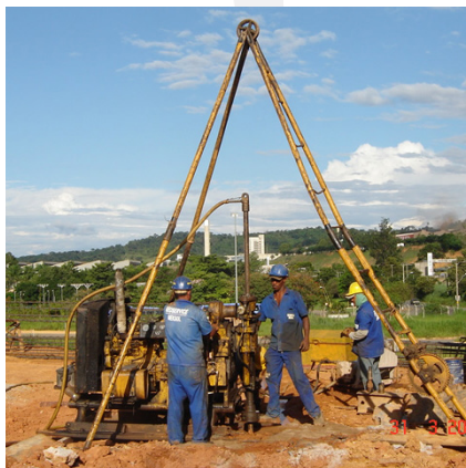
Sondagem por rotação
