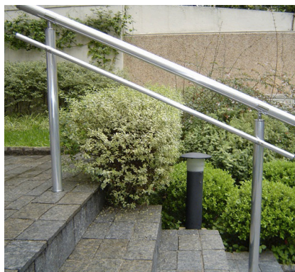
Corrimão em ótimo estado de conservação
