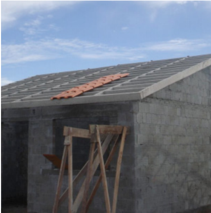
Estrutura do telhado em concreto
