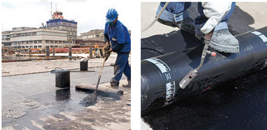
Mantas são aderidas à superfície com asfalto oxidado a quente ou com maçarico a gás.
